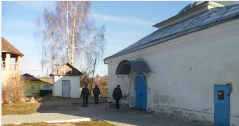
Ремонт фасада Церкви Святой Живоначальной Троицы (г. Мосальск)
